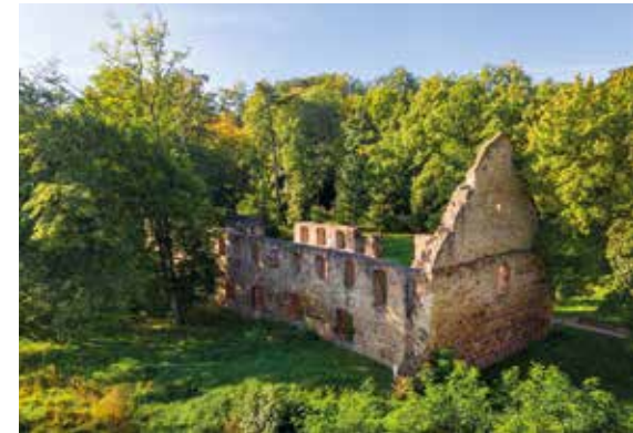
Ruine des Konventsgebäudes des Zisterzienserinnenklosters Nimbschen; Foto: Falk Opelt.
